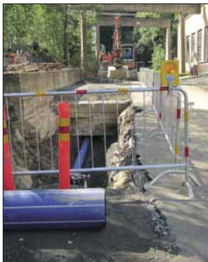
Sprinklausjärjestelmän rakentaminen alkoi maanalaisen putkiston rakentamisella.
